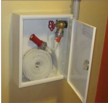
(Tuletõrje voolikusüsteemi kapp)
